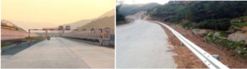
3.2.2 施工便道应考虑施工荷载进行专门设计，满足荷载需要，施工便道主线面层形式采用沥青混凝土结构形式，引入线面层形式可采用沥青混凝土或水泥混凝土结构形式。
