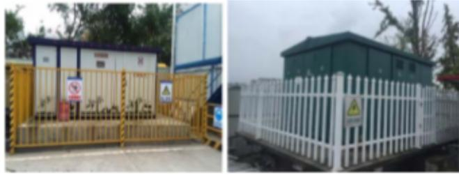
4.2.2 一级、二级配电箱设置防护棚架，防护棚架主框架采用 50mm 方钢焊制，其余采用 30mm 方钢，方钢间距按 15cm 设置，高度 2.4m，长宽 1.5-2m，正面设置栅栏门。
