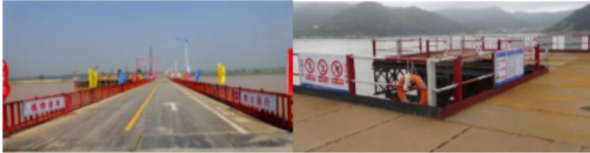
4.2.5 栈桥、码头按相关消防设计规范和应急救援的有关规定设置消防器材和救生设施，栈桥两侧每隔 25m 应分别配置 1 只救生圈，救生圈应方便取用。
